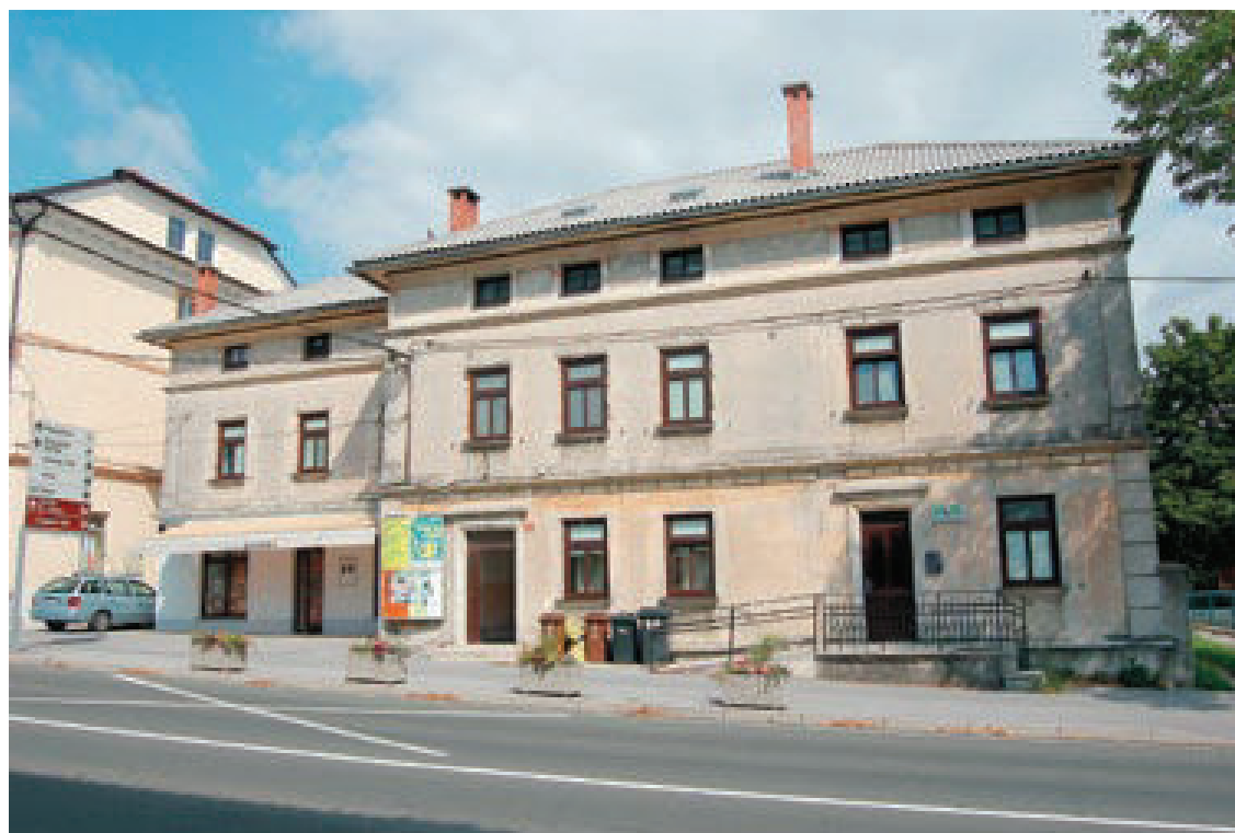
Pivka, Kolodvorska cesta 4, objekt pred prenovo v letu 2011 (foto: E. Belingar, 2011)
