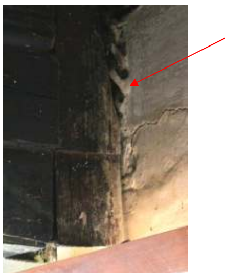
Glavni stropnik je v Z steno hiše vpet preko verige.
