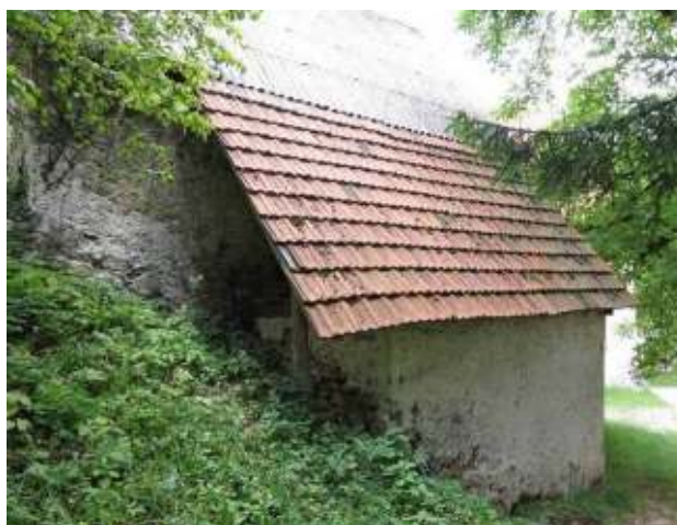
Prizidek h kašči, prekrit z opečnim zareznikom.
