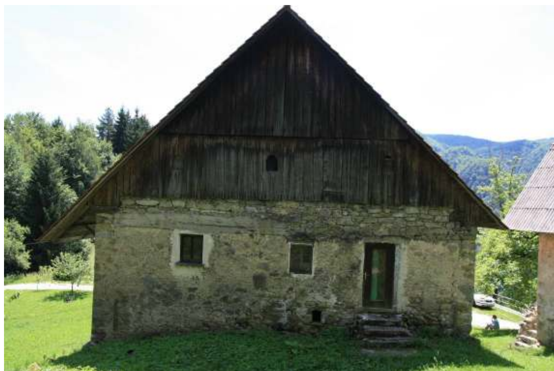
Pogled na S fasado.
