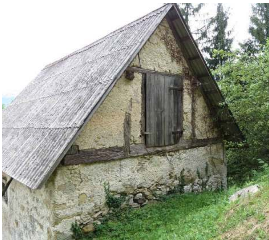
Pogled na severno fasado.
