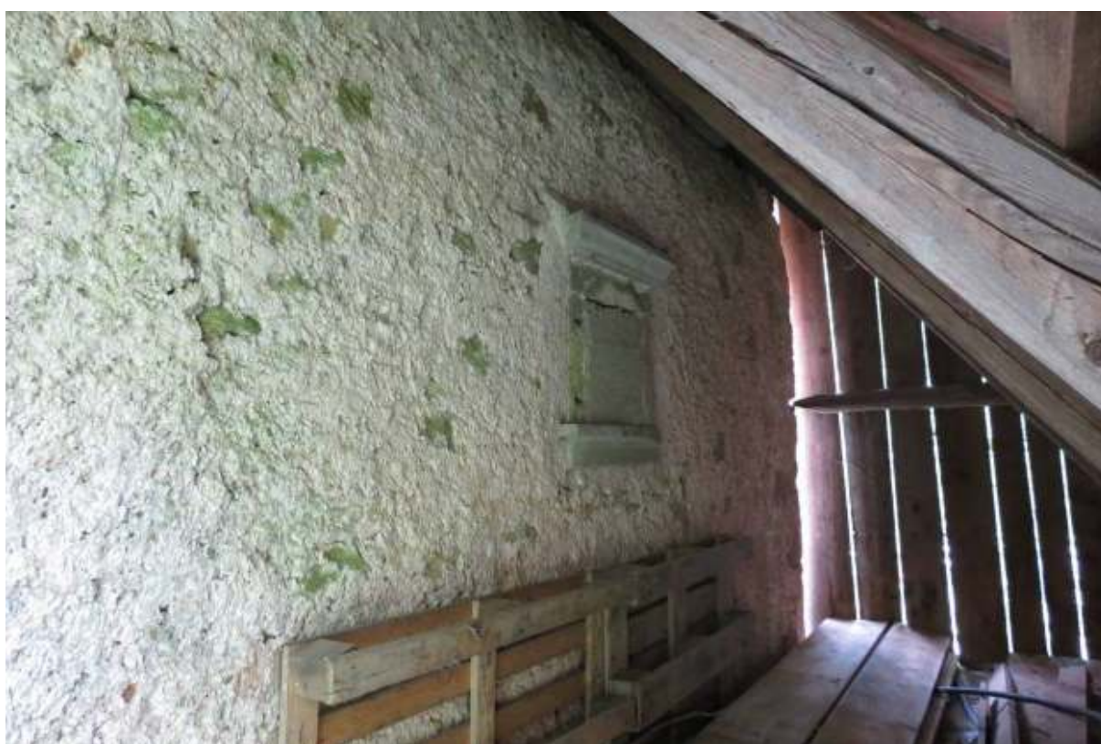
Z fasada z zazidanim oknom, skrita pod streho prizidka.
