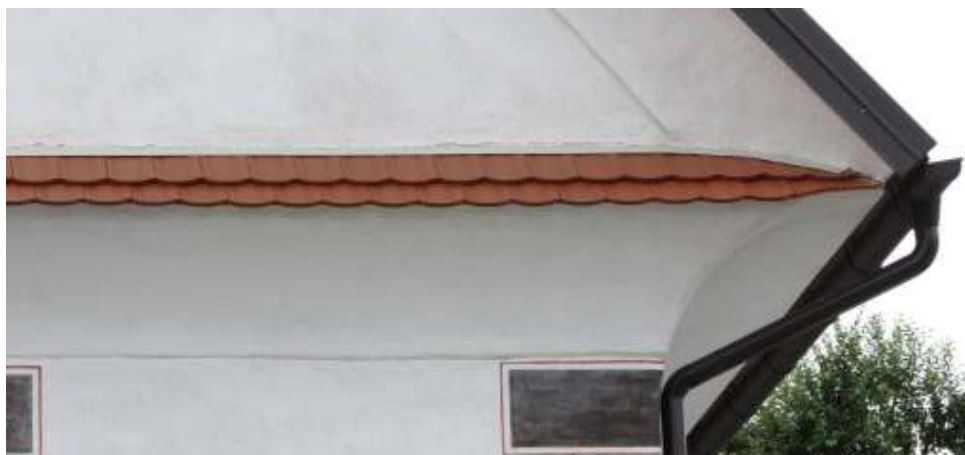
Primer ločnega, ometanega in z bobrovcem kritega delilnega zidca pod zatrepom fasade. Viden tudi ločno zaključen odkap.
