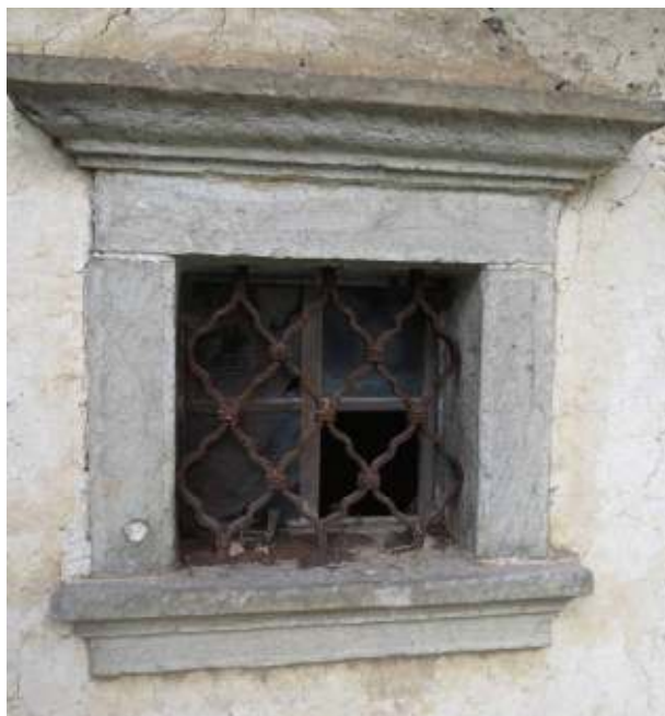
Levo: Kamniti okenski okvir s kovinskimi gavtrami na kašči. Desno: Kamniti portal v gorenjo klet.
