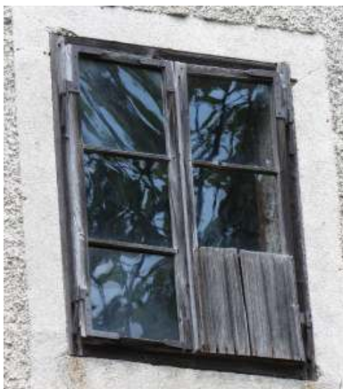
Ohranjeno zunanjo okno na zatrejni fasadi.
