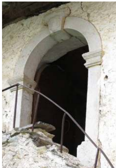
Levo: Kamniti okenski okvir s kovinskimi gavtrami na kašči. Desno: Kamniti portal v gorenjo klet.
