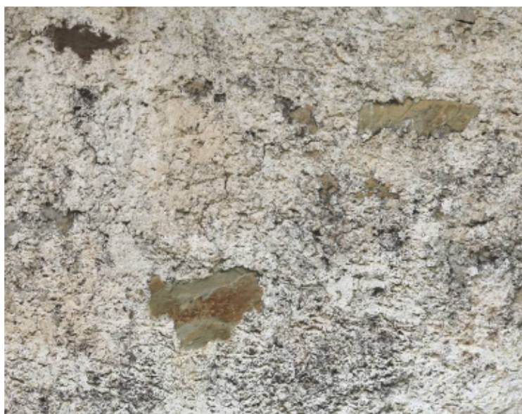
Grobi omet, zaglajen na način, da ostanejo nekatere kamnite površine vidne.
