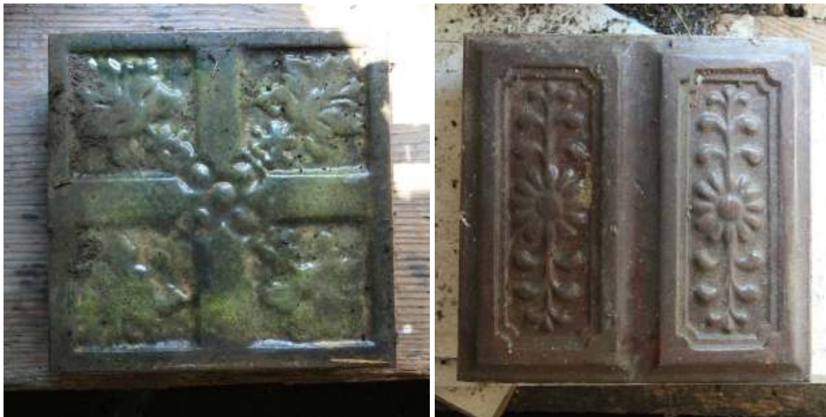
Dva primera v hiši ohranjenih pečnic, ki se jih uporabi za pozidavo podrtih peči.
