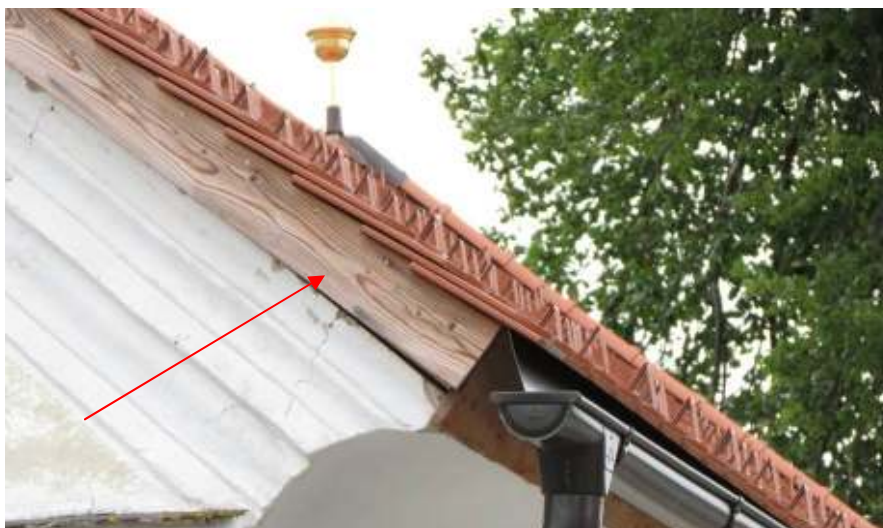
Primer čelneza zaključka, izvedenega z leseno desko.
