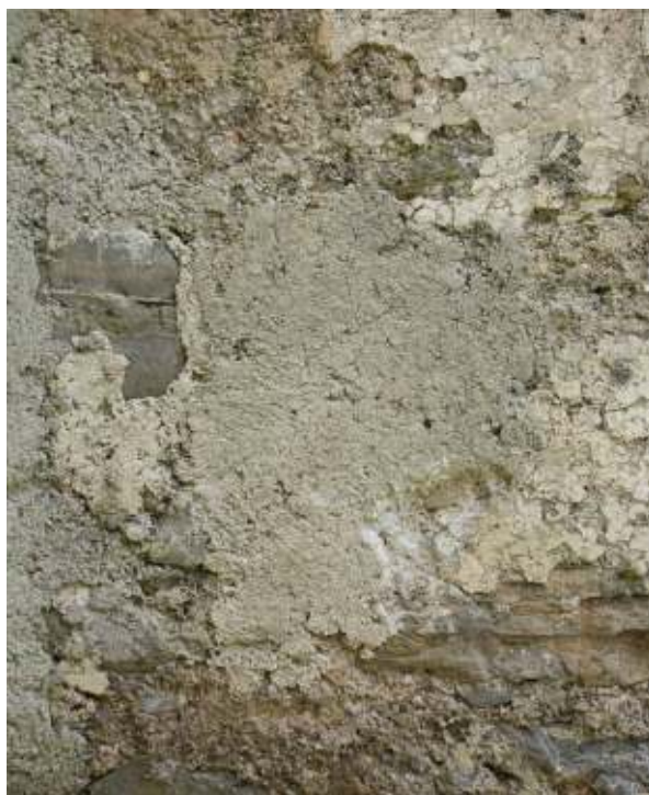
Zazidana niša desno od vhodnih vrat.
