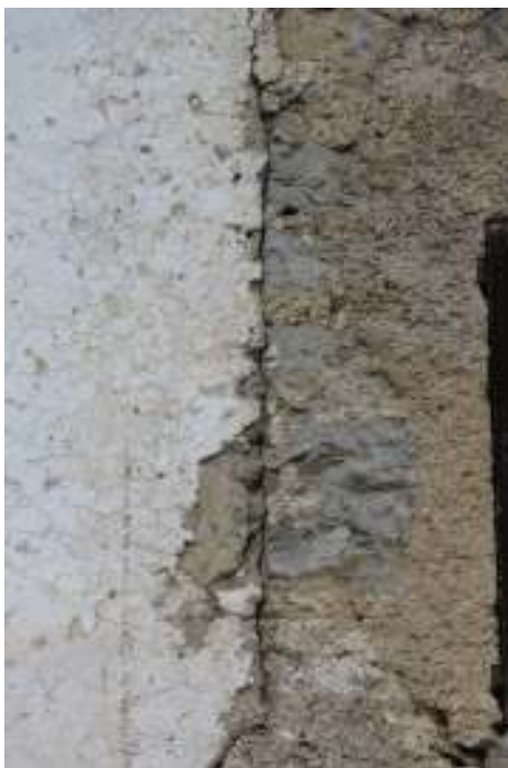
Dilatacija v zidu.
