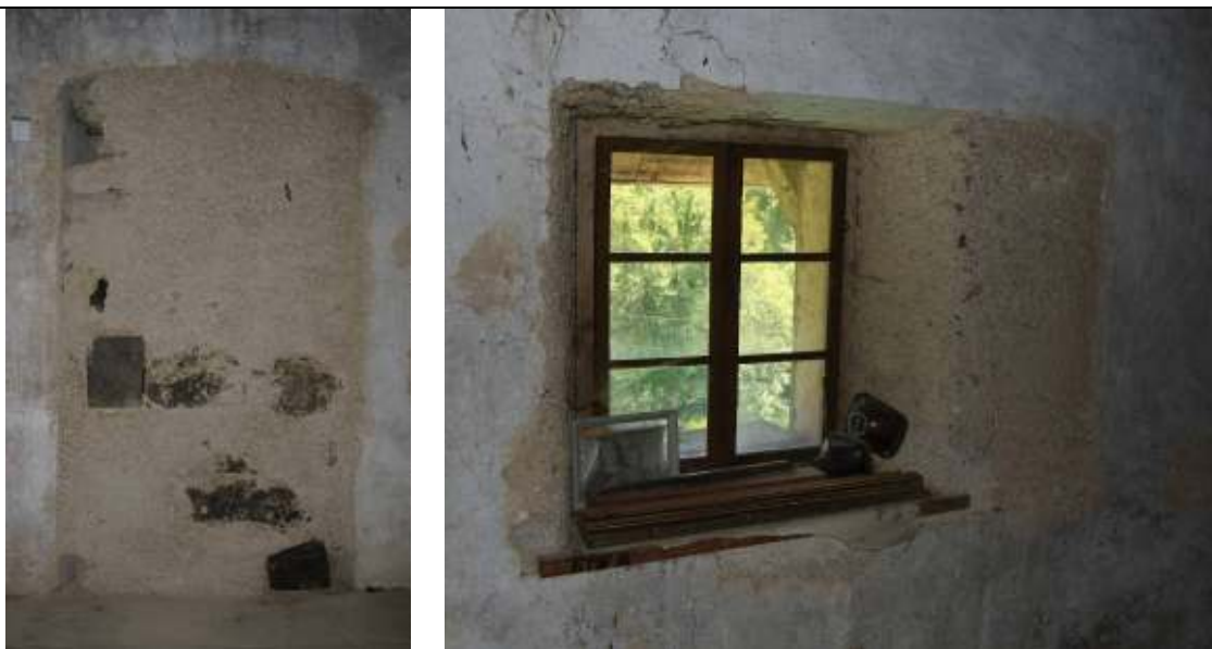
Levo: Zazidana vratna odprtina na gank z vidnimi vgrajenimi obdelanimi kamni. Desno: Okno ob vratih na gank je bilo zamaknjeno v levo (vidna dozidava desno).
